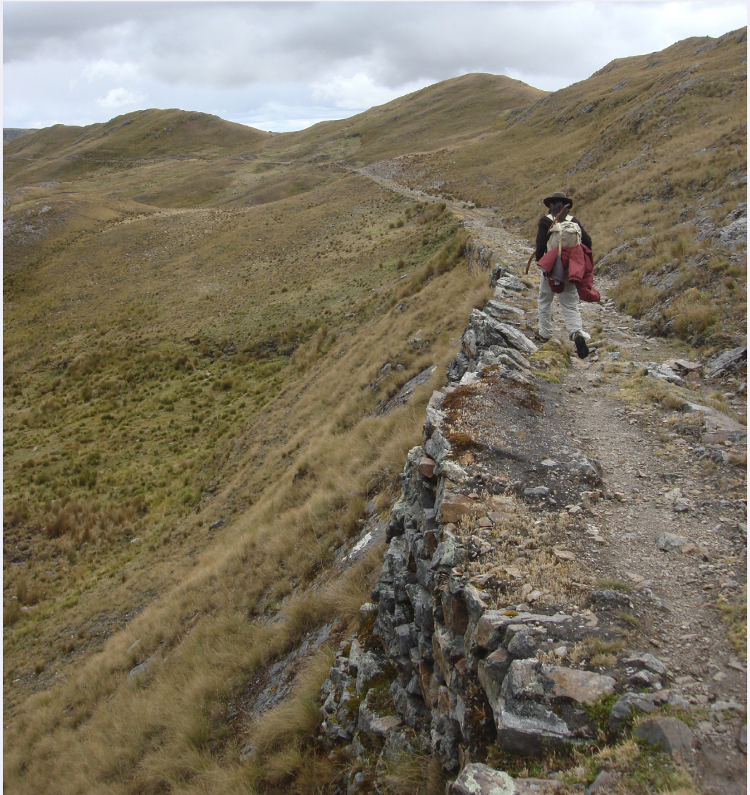
FIGURA 3. Camino tipo plataforma corte-talud, en las alturas de la provincia de Huari (Áncash). Fotografía: Ricardo Chirinos Portocarrero (Proyecto Qhapaq Ñan).
